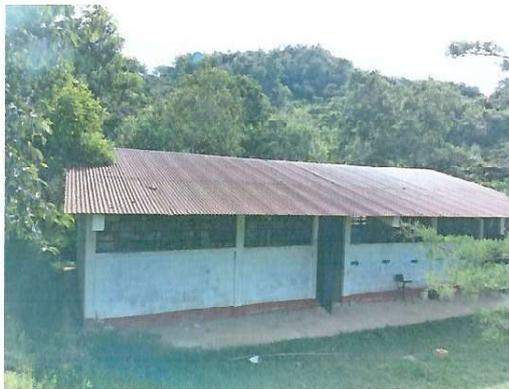
Foto 1: Cubierta de Lámina de 2 aulas, y pintado de costanera.
